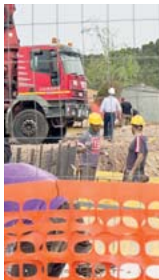
Operai in un cantiere
